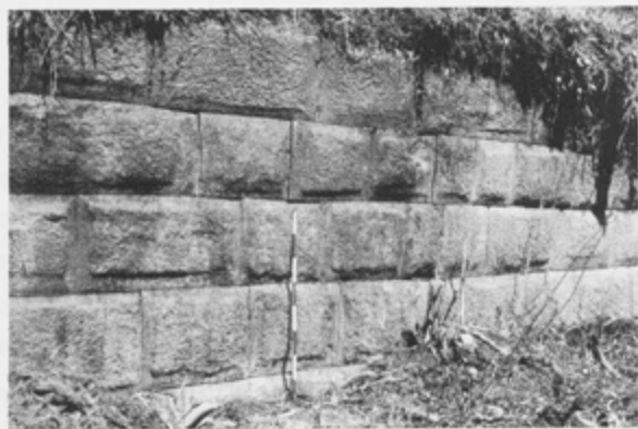
D76. PCH-III. Plataforma 10 - Aparejo sedimentario.
