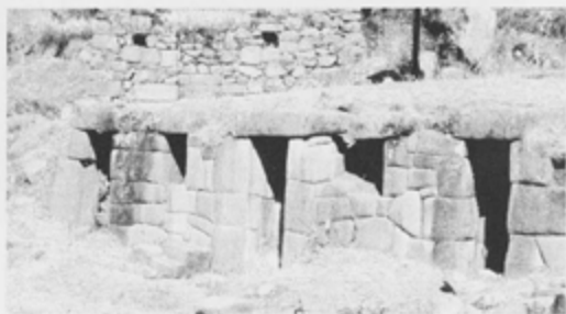
D47. PCH-III. Plataforma 4. Nichos.
