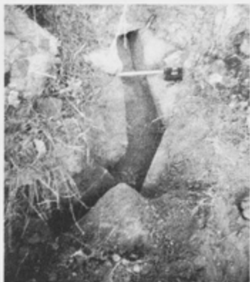
F50. PCH-III. Canal subterráneo PL. 1.
